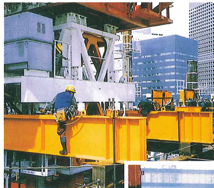
ベル受架台設置状態
