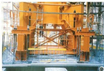
4. 油圧ホースを配管し、電源をクレーン本体から継ぎ込んで組立を完了します。(写真⑥)
