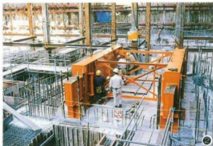
1. 本設鉄骨梁又はRC梁等タワークレーンを設置しようとする箇所に、2本のベース受架台を載せそれぞれを垂直プレスで締めます。(写真①、②)
