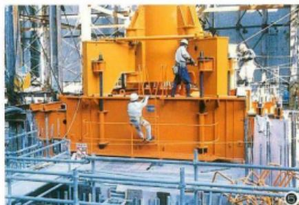
3. クライミング架台のうえにタワークレーン折りたたみ架台を載せ、カンザシとボルトで固定します。(写真④、⑤)
