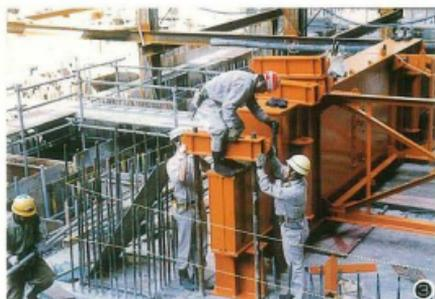
2. アウトリガーと本設梁等を、ボルトとカンザシにより固定します。(写真③)
